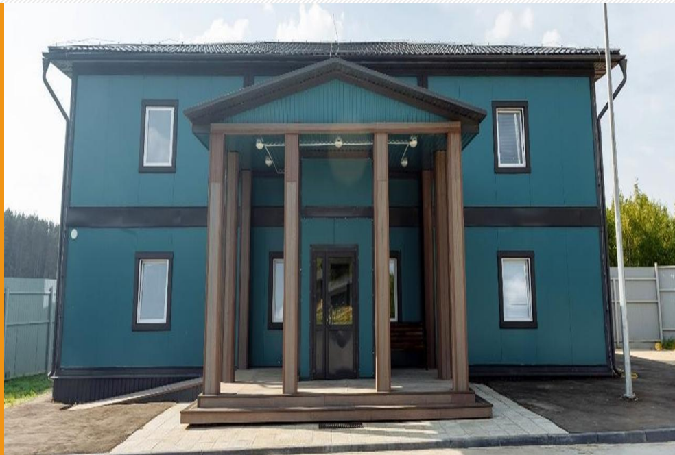
Здание АБК, Республика Хакасия.
